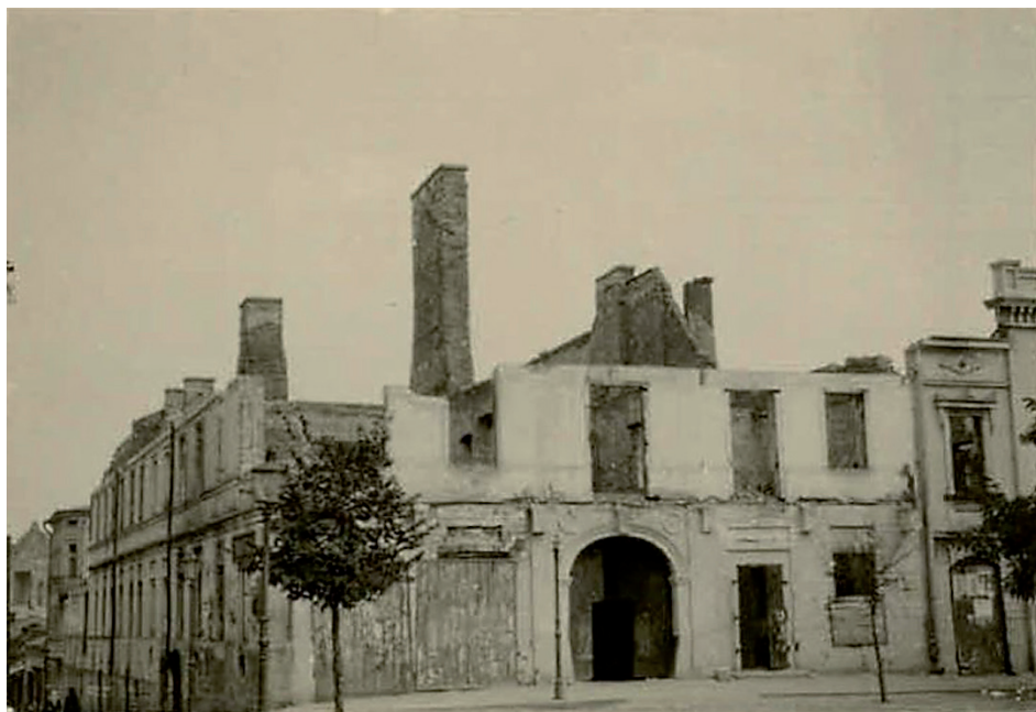
Fot. 17. Ruiny kamienicy Lauterbacha na rogu ulic Kowalskiej i Rynkowej. Zdjęcie 1915 r.
